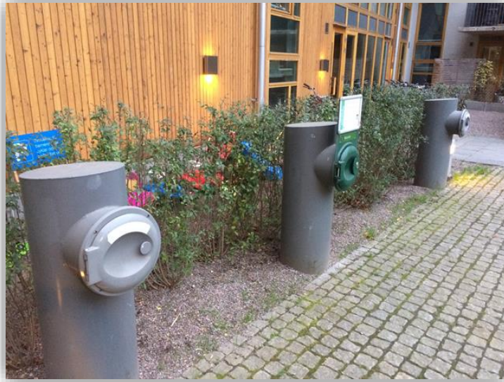
27. ábra: Hammarby Sjöstad – Személedobó a föld alatti rendszerhez (saját fotó)
