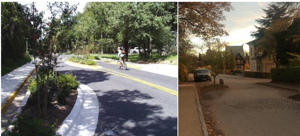
64. ábra: Épített szegély, síkán kialakításával (Forrás: www.nacto.org , saját fotó - Kopenhága)
